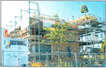
Seit gestern weht auf dem Dach der DRK-Kita die Richtkrone. Die Fertigstellung verzögert sich um gut ein halbes Jahr. Fotos (2): Christel Ros
